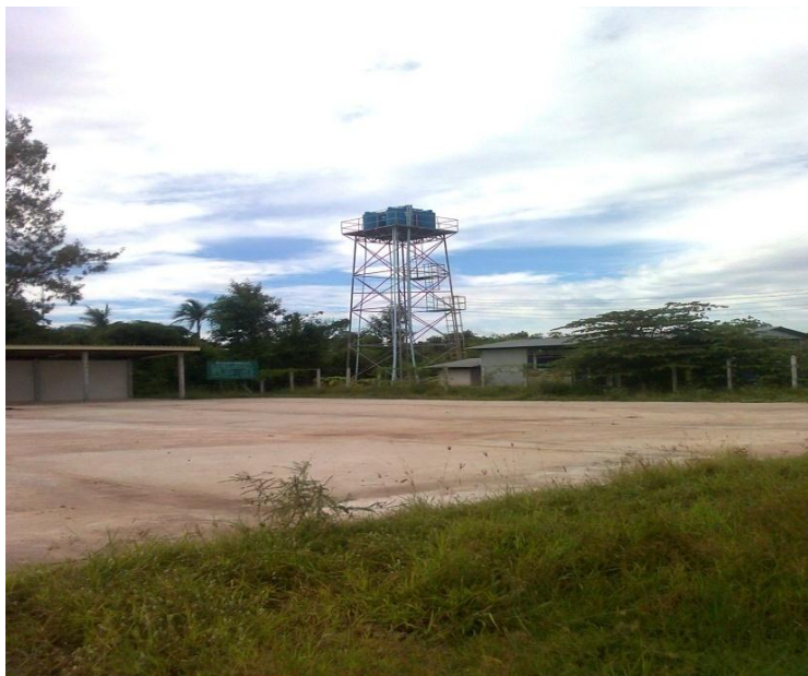
รูปที่ 1.3 ระบบประปา บ้านหนองเชียงชา หมู่ที่ 16
